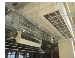
体育館等への空調設置
