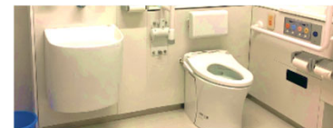
避難所としての 防災機能強化 (バリアフリートイレの整備)
