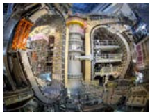
6つ目のセクターモジュール設置完了(2026年7月)
