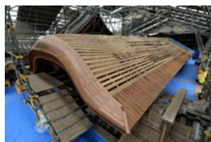
檜皮葺の様子 【重要文化財・妙心寺（京都府京都市）】
