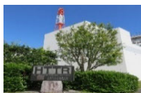
HTTR (高温工学試験研究炉)
