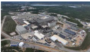
ITERサイトの建設状況
